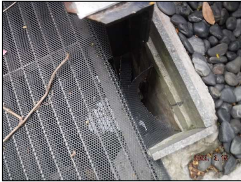
บ่อพักน้ำสุดท้ายของระบบระบายน้ำของโครงการก่อนระบายลงสู่ระบบระบายน้ำบริเวณด้านหน้าโครงการ วันที่ 15 มีนาคม พ.ศ. 2566 (ต่อ)
